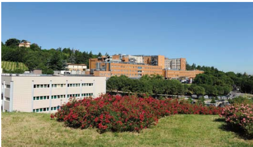
Una veduta panoramica dell'Ospedale Bufalini di Cesena
